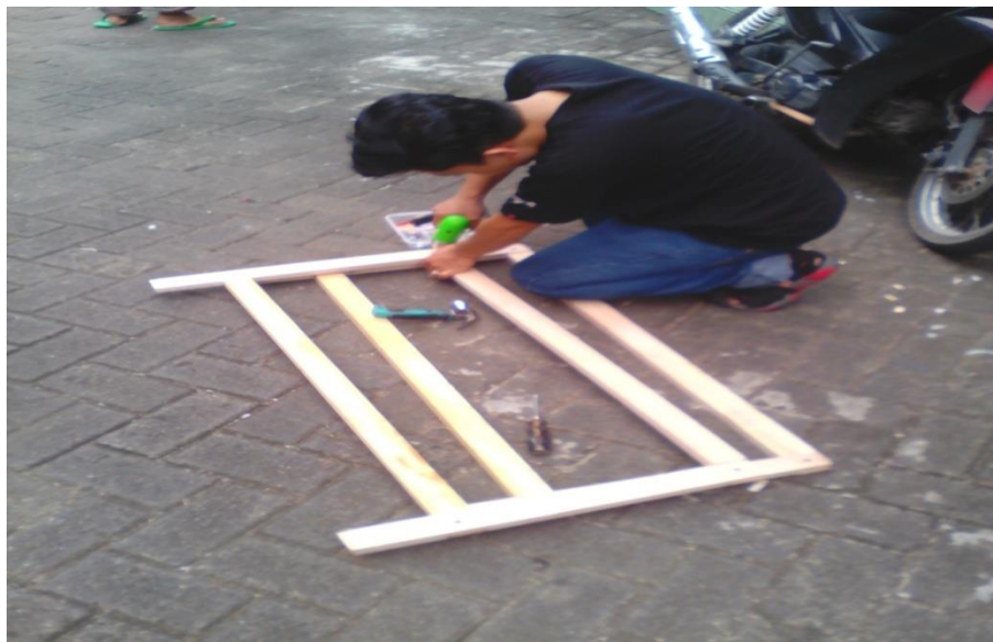
Proses pemasangan balok pada tiang
