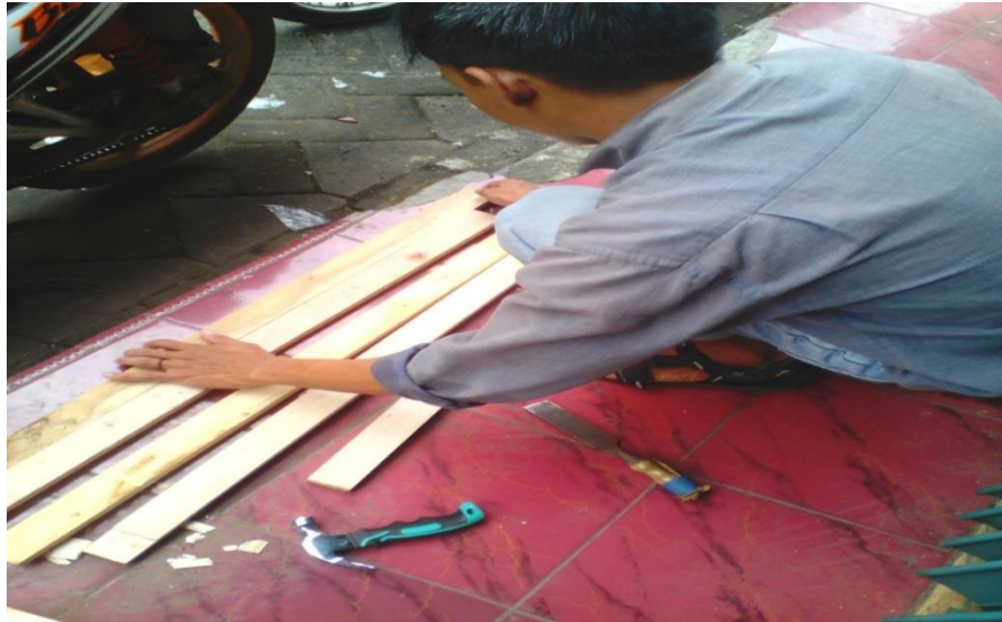
Proses pengukuran dan pemotongan balok
