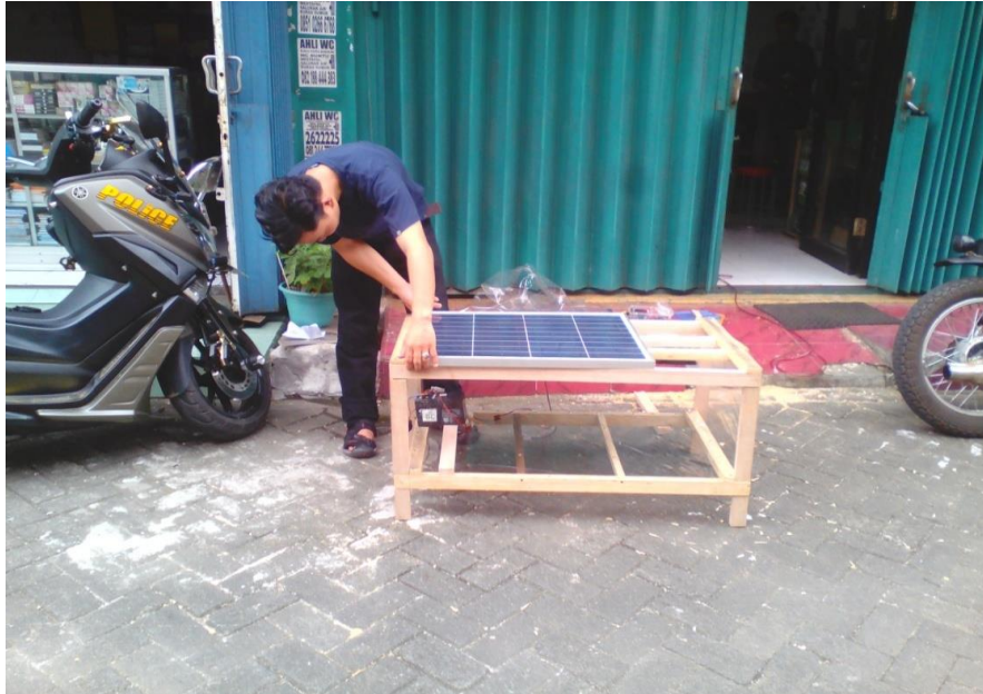
Proses pemasangan semua alat sistem elektrik drive berbasis solar photovoltaic pada model ruangan ventilasi
