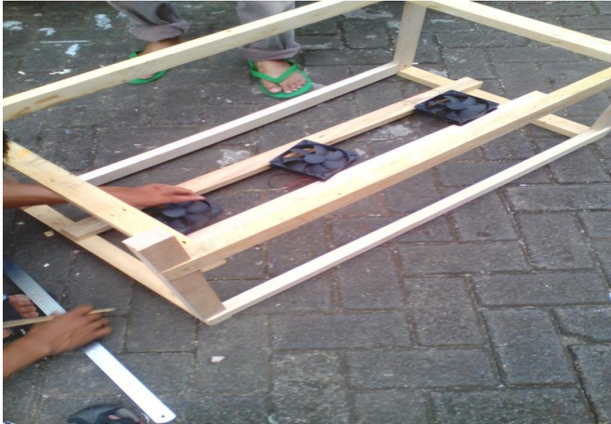
Proses pemasangan kipas pada model ruangan ventilasi
